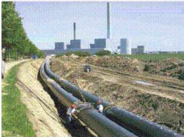
**Figura 23a - Instalação de tubulações de uma grande rede de Aquecimento Distrital com visão da central termelétrica ao fundo (Lombardia – Itália)**
